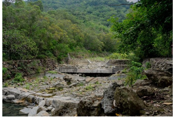
圖4：龜丹溪流域現場
