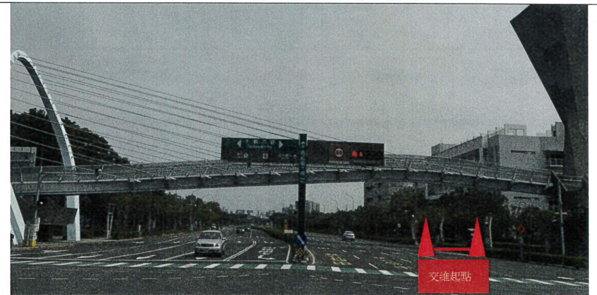
西拉雅大道(南側)路邊停車線現況
