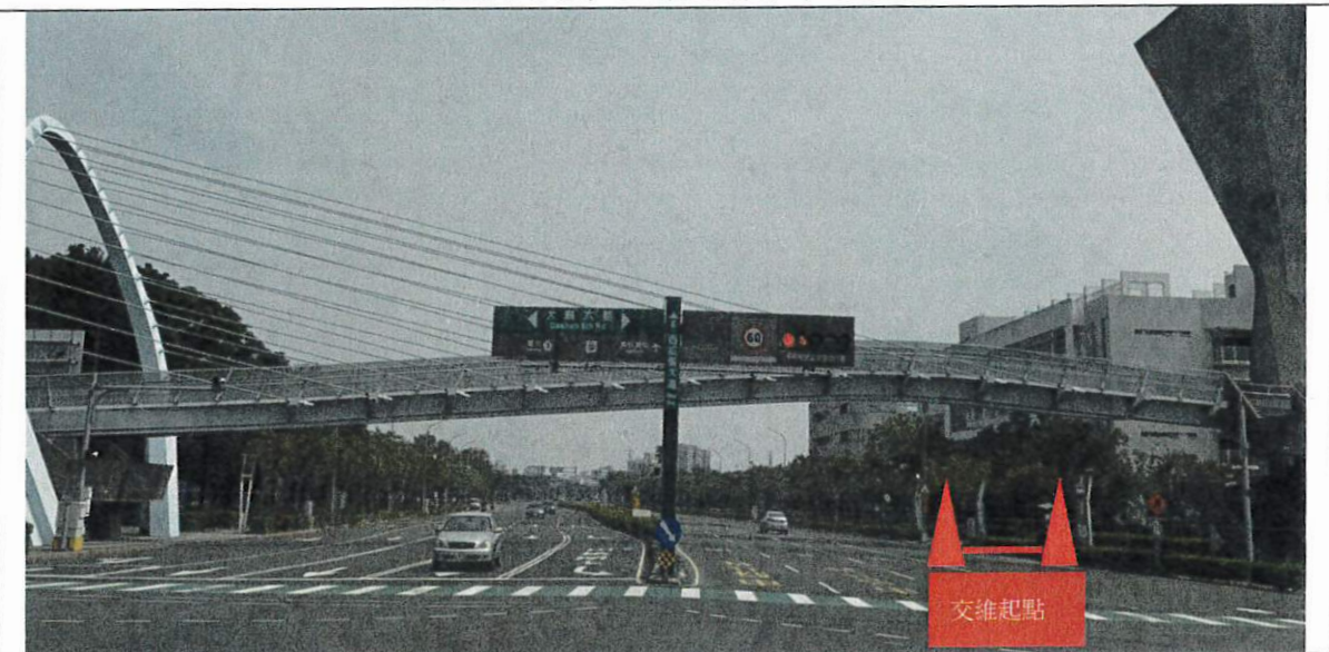
西拉雅大道(南側)路邊停車線現況
