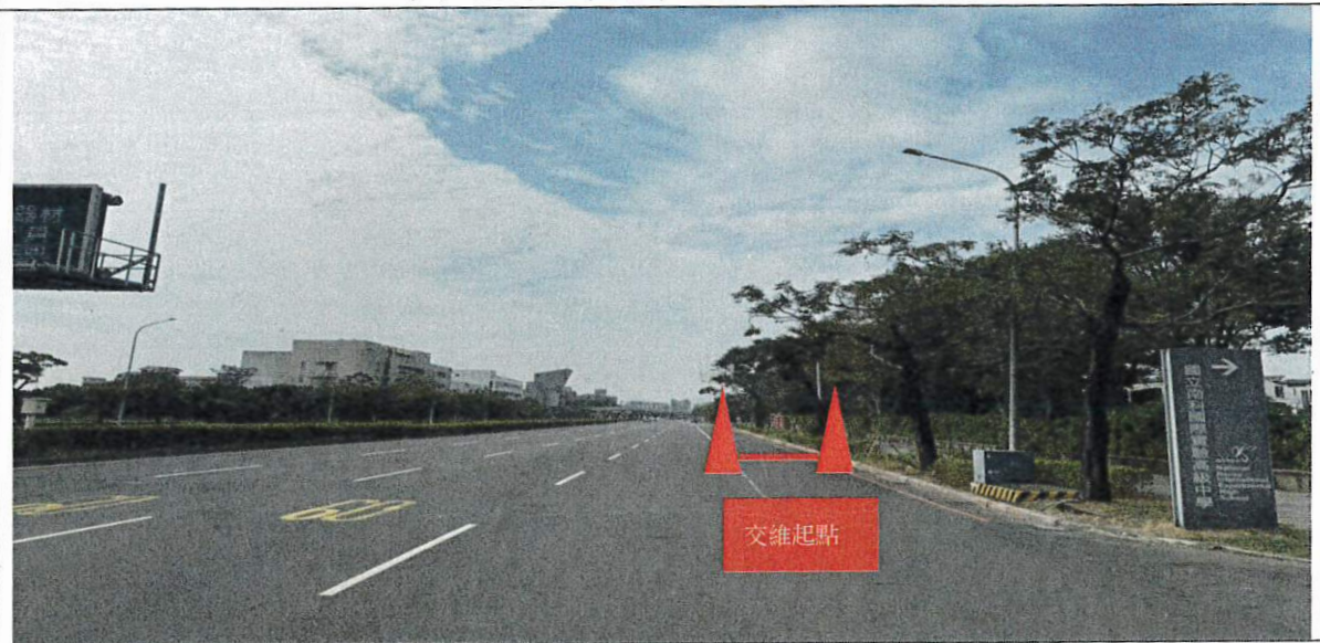
西拉雅大道(北側)路邊停車線現況
