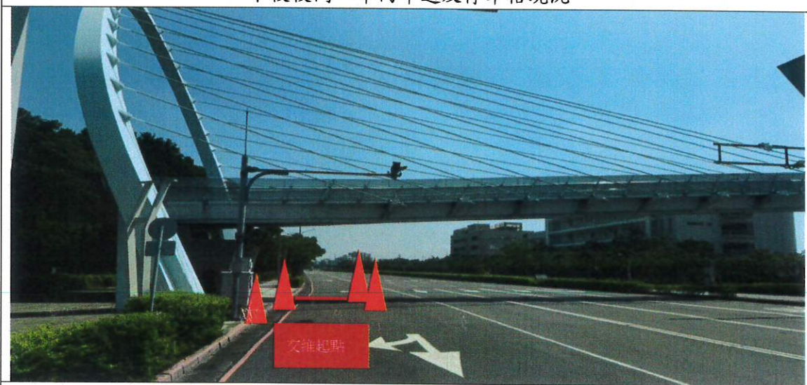
西拉雅大道車道現況
